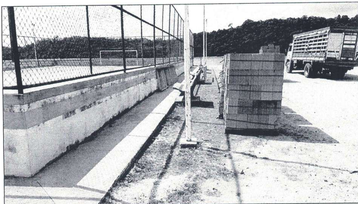
Foto 03 - Área do Cais de Arrimo
