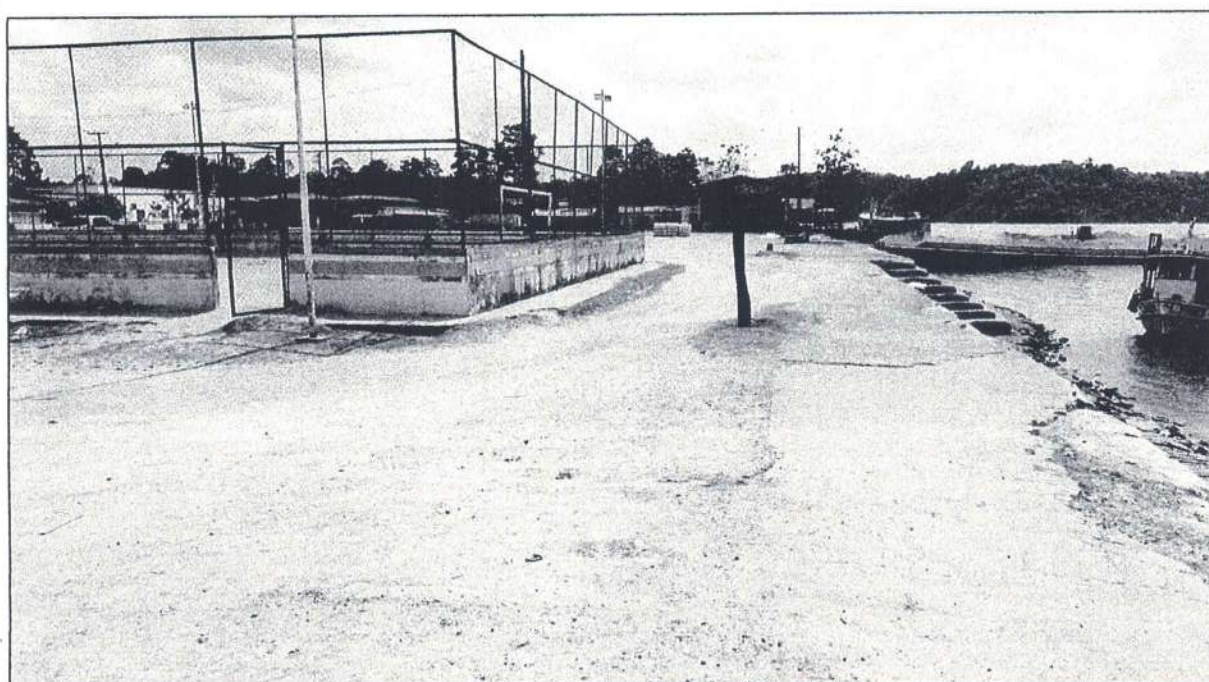
Foto 04 - Área do Cais de Arrimo
