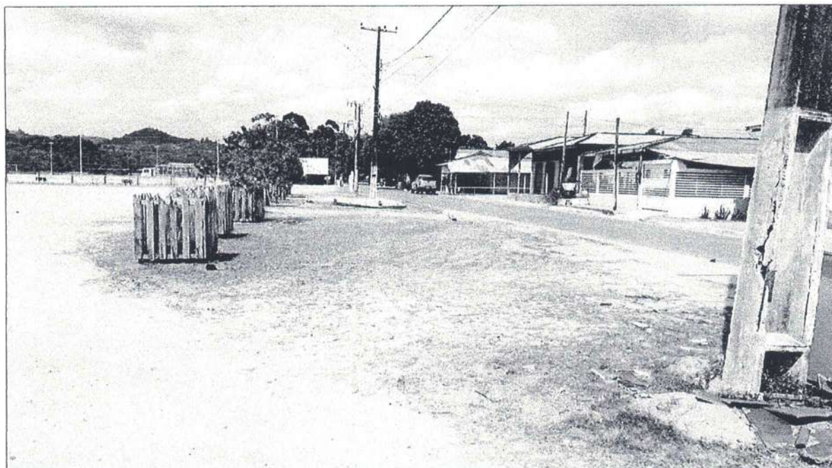
Foto 01 – Área do Cais de Arrimo
