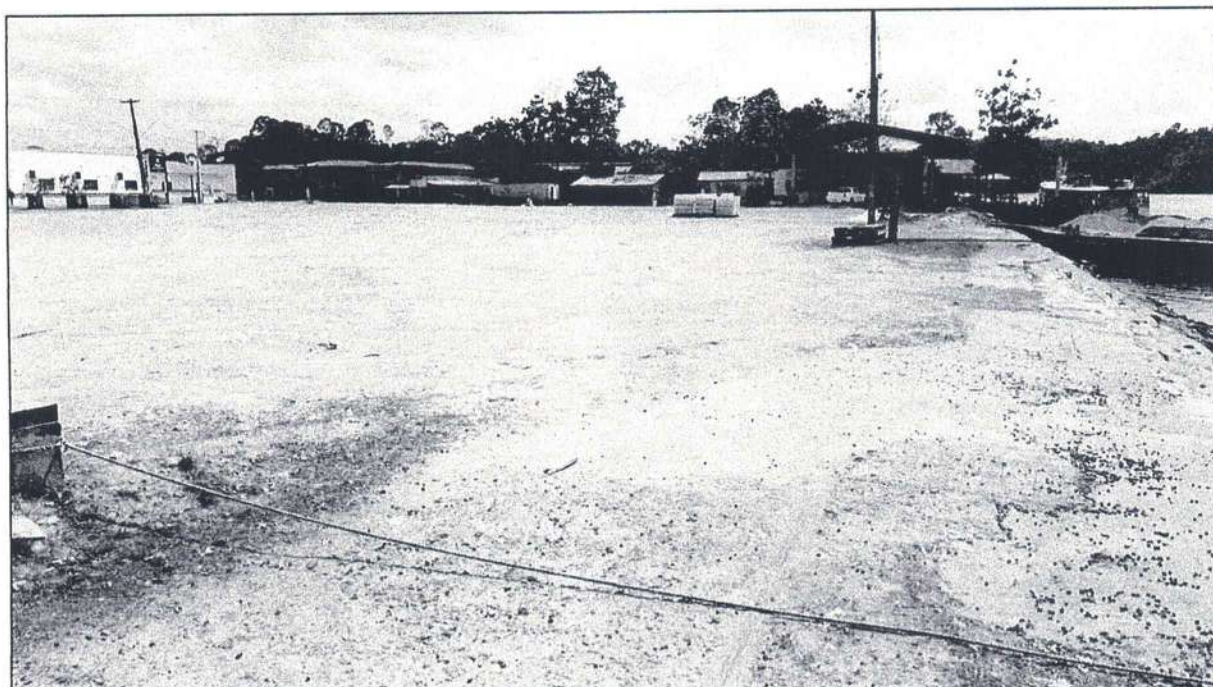
Foto 05 - Área do Cais de Arrimo
